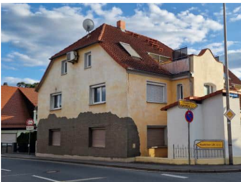
Abb. 37: defizitäre Fassadengestaltung Erlanger Str. 1
