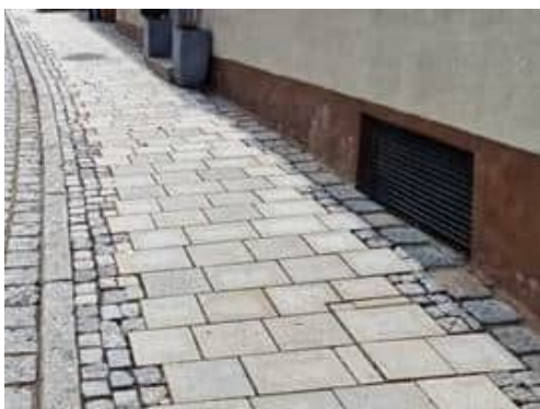
Abb. 114: Beispiel barrierefreier Pflasterbelag
