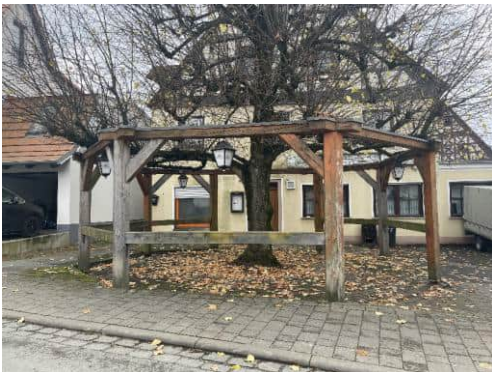
Abb. 105: Stützkonstruktion der Linde am Merkersaal
