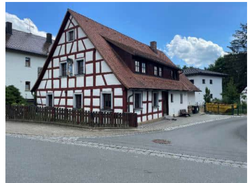
Abb. 91: gut gestaltete Fachwerkfassade Bergstr. 6
