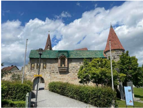
Abb. 96: Dach der Kirchenburg mit Notsicherung
