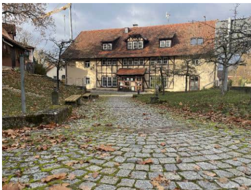
Abb. 116: gepflasterter Zugang zum Rathaus
