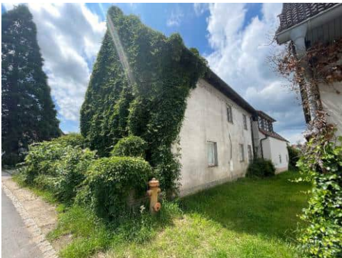
Abb. 92: leerstehendes Wohngebäude Mittlerer Bühl 12
