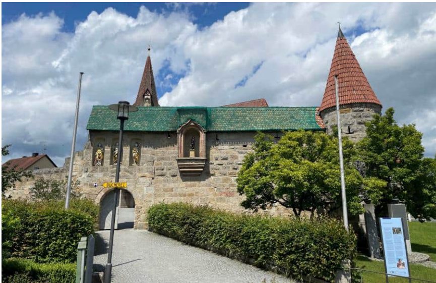
Abb. 1: Wehrkirche im Ortskern
